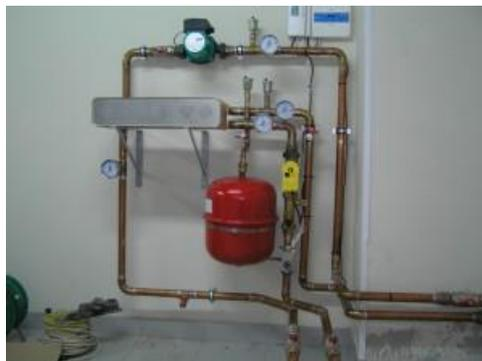
Рисунок 3 – Водяная система обогрева
