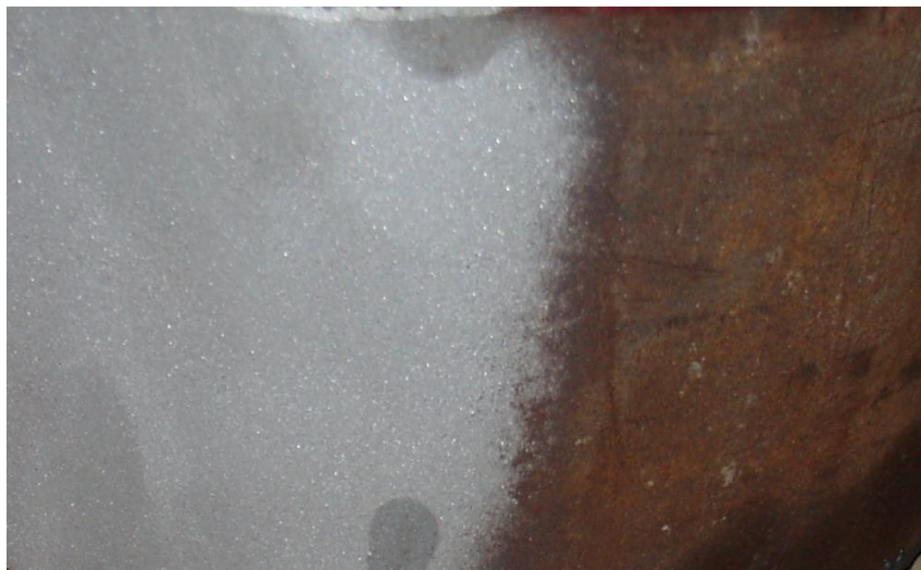
Рисунок 3 - Снятие окисных пленок с поверхности металлоконструкции
