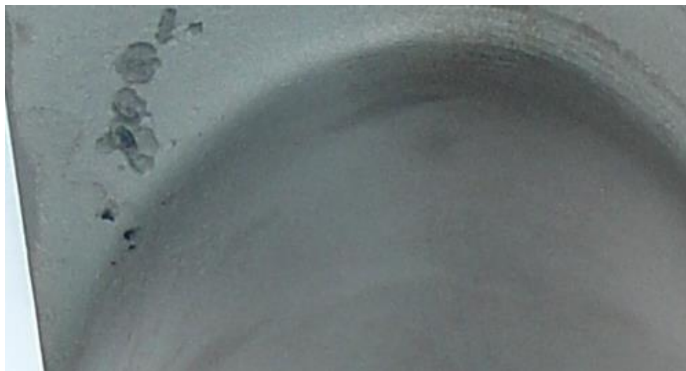
Рисунок 1 - Вскрытые дефекты поверхности в результате гидроабразивной обработки
